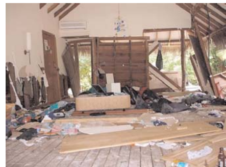
Die Insel wird geschlossen. Sie muss komplett neu aufgebaut werden.
